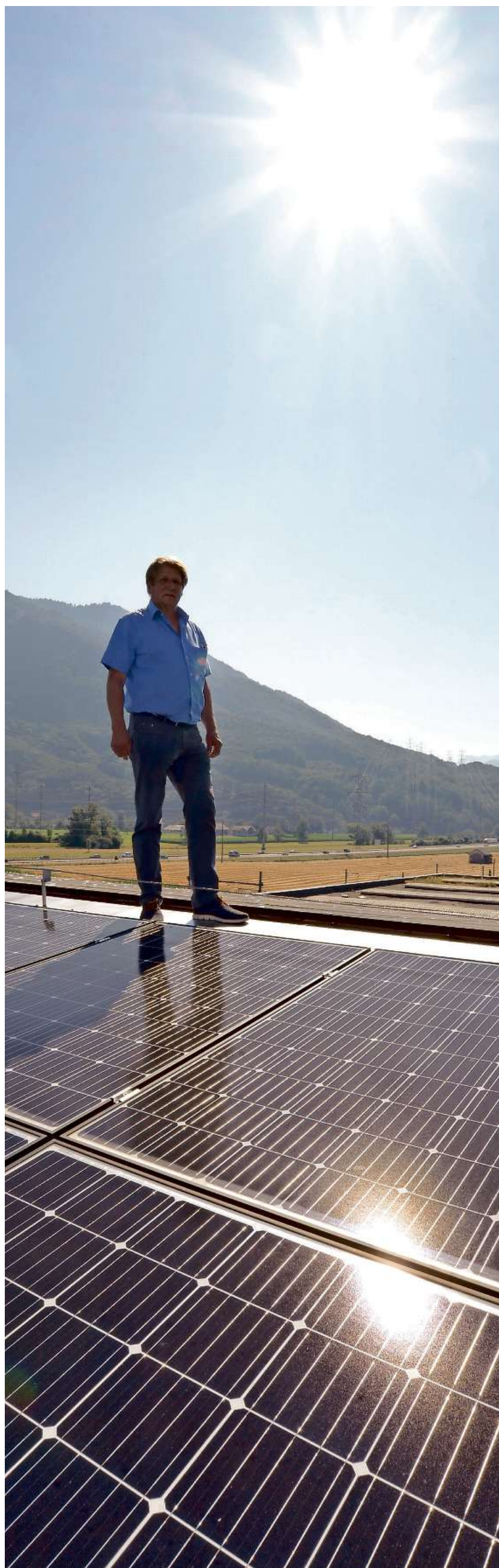
Strom vom Himmel: Ignaz Luchsinger produziert auf der ganzen Dachfläche seiner Firma in Bilten Solarstrom. Bild Fridolin Rast
